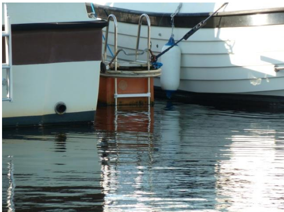
Redningsstiger er plassert på enden av hver 4. utligger
